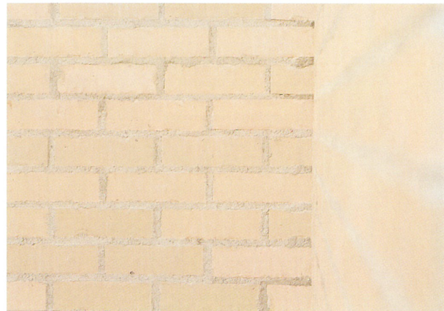
Um den gewünschten Effekt in der Oberfläche zu erreichen, wurden Fehler, die in der heutigen Zeit vermeidbar sind, in der Produktion wieder zugelassen. So entstand ein Ziegel, dem man seinen Fertigungsprozess ansieht.
